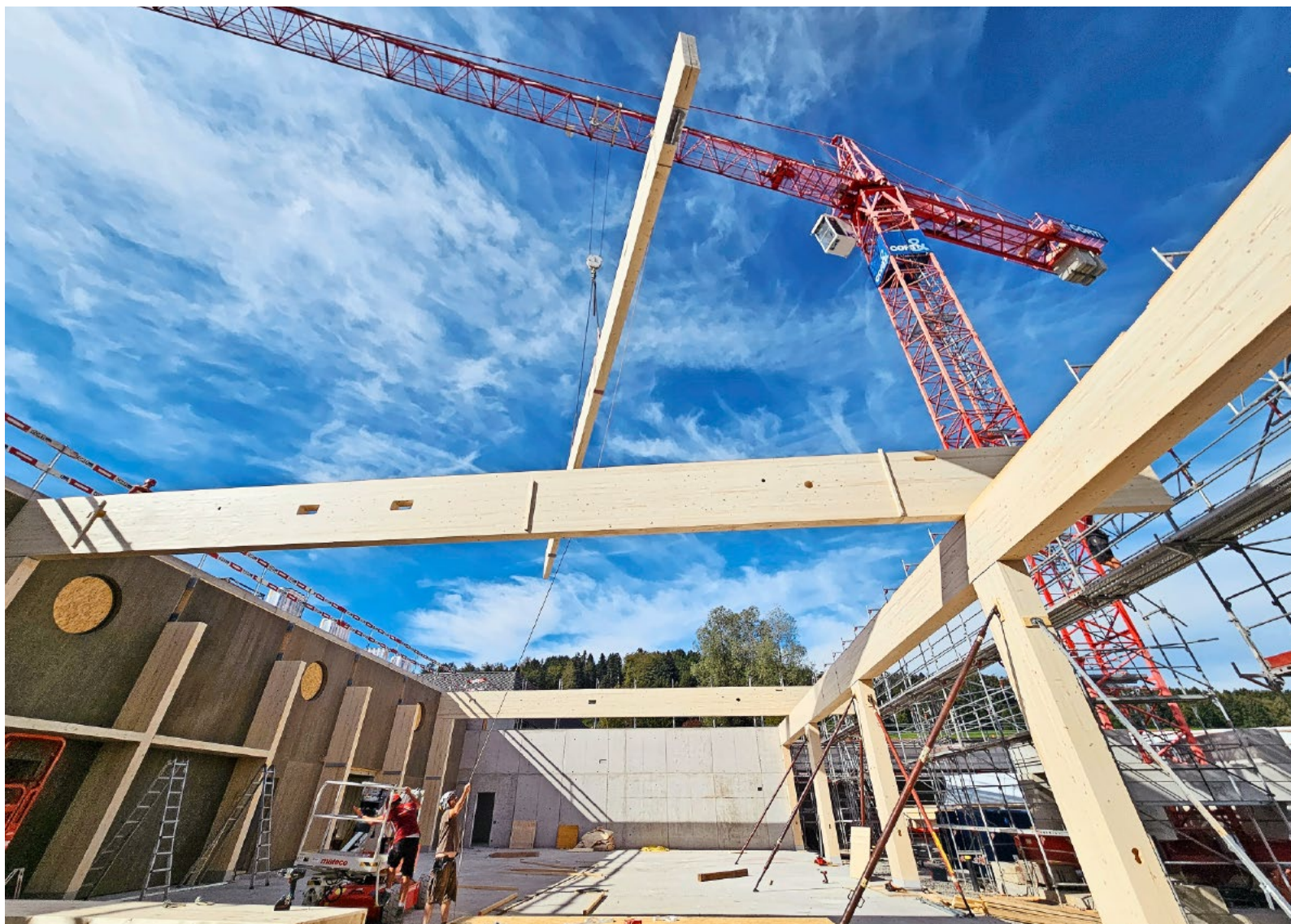
Action auf der Baustelle des BSG. Am Kran schwebt ein Holzbinder durch die Lüfte. Unten im Bild leitet der Arbeiter mit einem langen Seil das Holzelement an seinen Platz.
