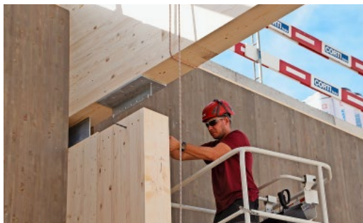
Hier muss der Arbeiter alle vorgebohrten Löcher noch einmal durchbohren, bevor das Holzelement endgültig herabgelassen wird und anschliessend riesige Schrauben eingedreht werden.
