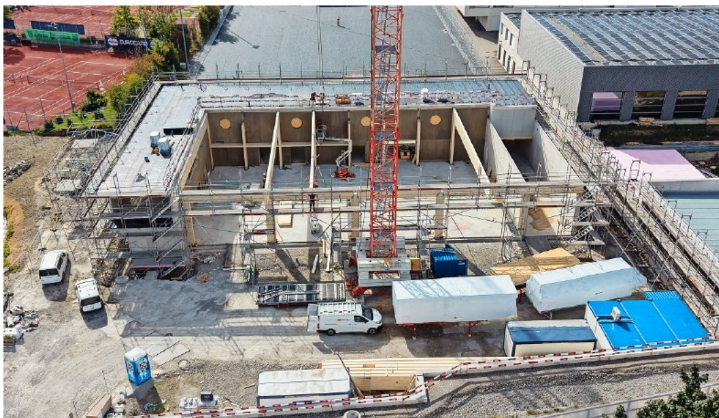
Einfahrt und Fahrzeugeinstellhalle (Mitte) und Waschbox (rechts), Kommando-/Aufenthaltsräume und Büro Feuerwehr (links). Hinten: Theorieraum, Garderoben, Werkstätten und Lagerräume für Feuerwehr, Zivilschutz und Samariter.
